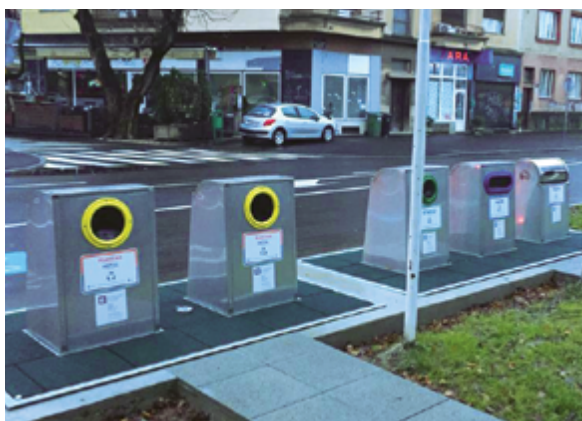
U 2018. nabavljeni su novi kompleti podzemnih spremnika s hidrauličkom platformom za odvojeno prikupljanje otpada.
